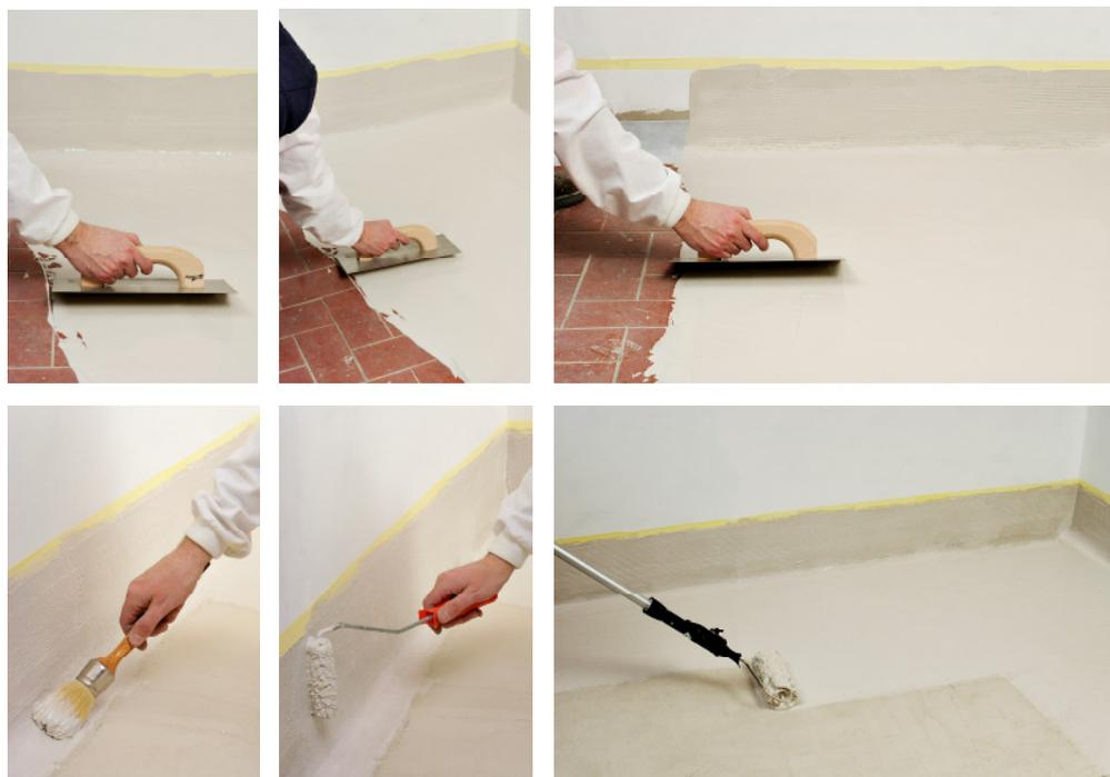
Nell'impermeabilizzazione di suoli, unione con le pareti, si raccomanda prolungare il rivestimento ad una altezza di ca. 15 cm.
